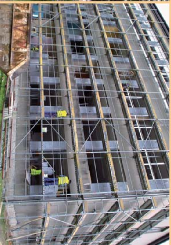
Revitalizace základní školy v plněm proudu. Foto: Jiří Pastor
