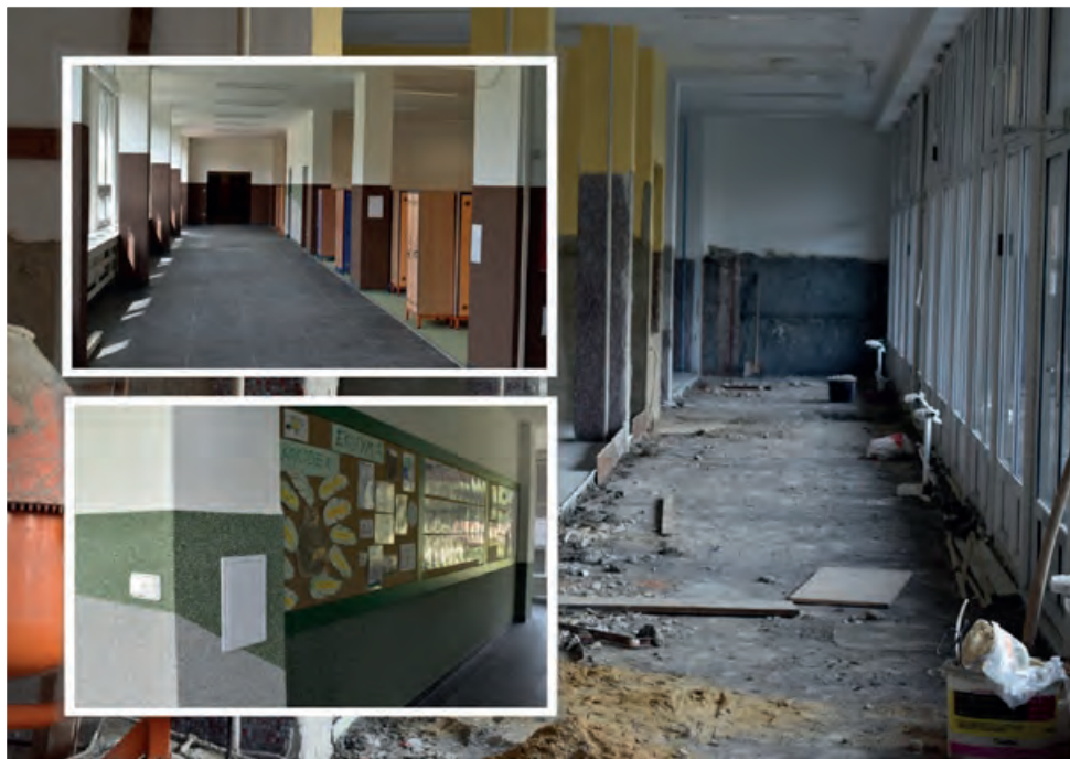
Chodba po rekonstrukci
